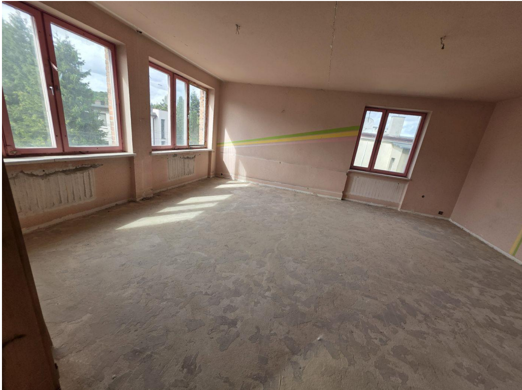
Fot. 11. Lokal po wymianie stolarki okiennej, wylewka (03.09.2026)
