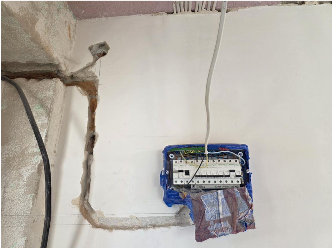
Fot. 7. Nowa instalacja elektryczna - puszka rozdzielcza (03.09.2026)
