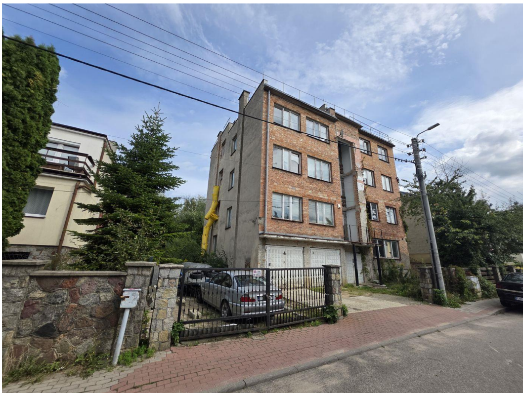
Fot. 2. Budynek od strony wjazdu i garaży (03.09.2026)
