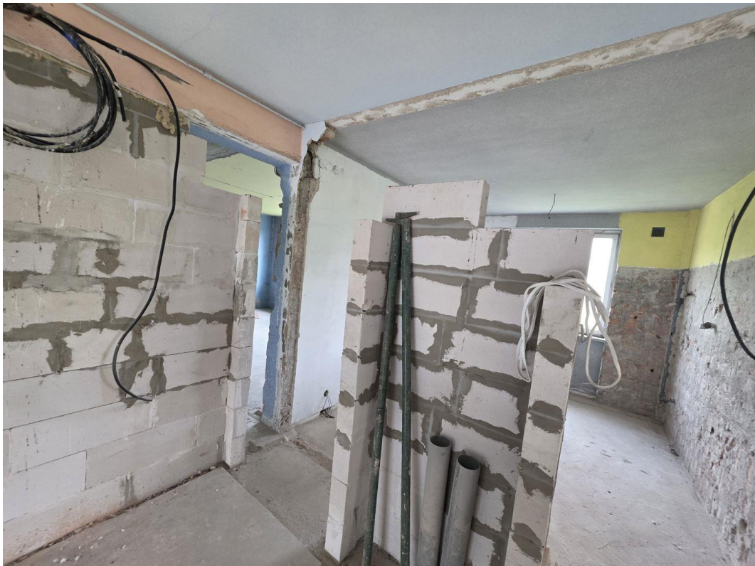
Fot. 10. Ścianki działowe z bloczków - kondygnacja w przebudowie (03.09.2026)
