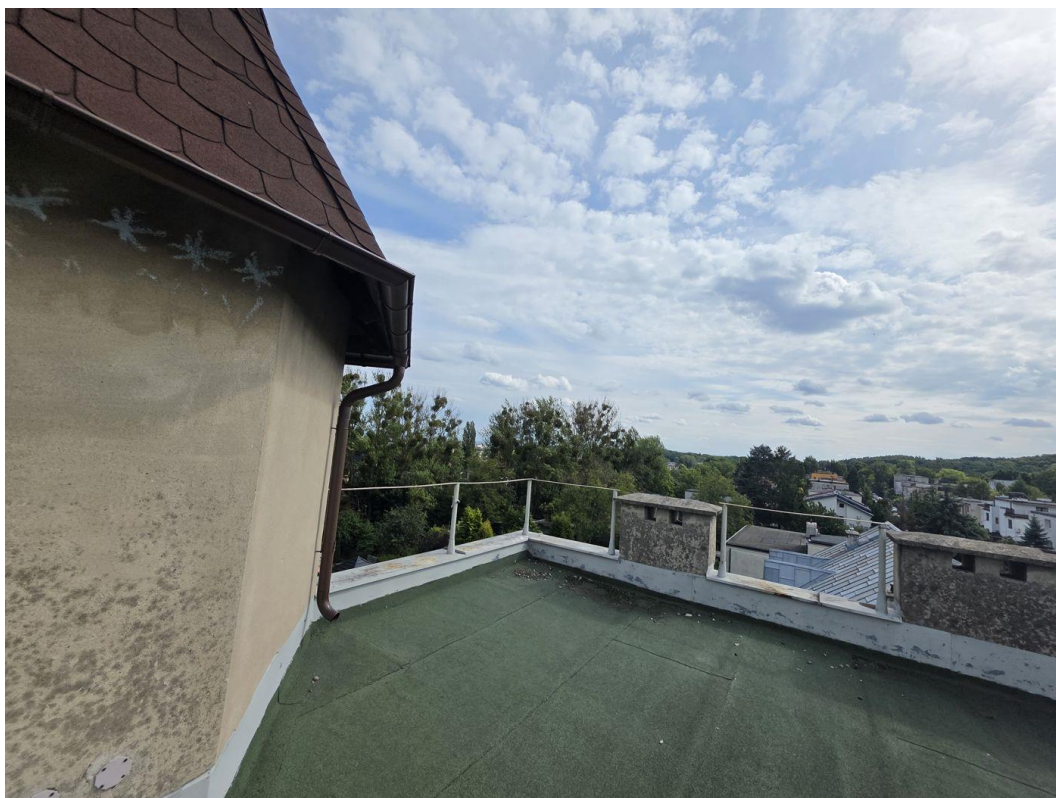
Fot. 4. Taras na dachu - balustrada i pokrycie (03.09.2026)
