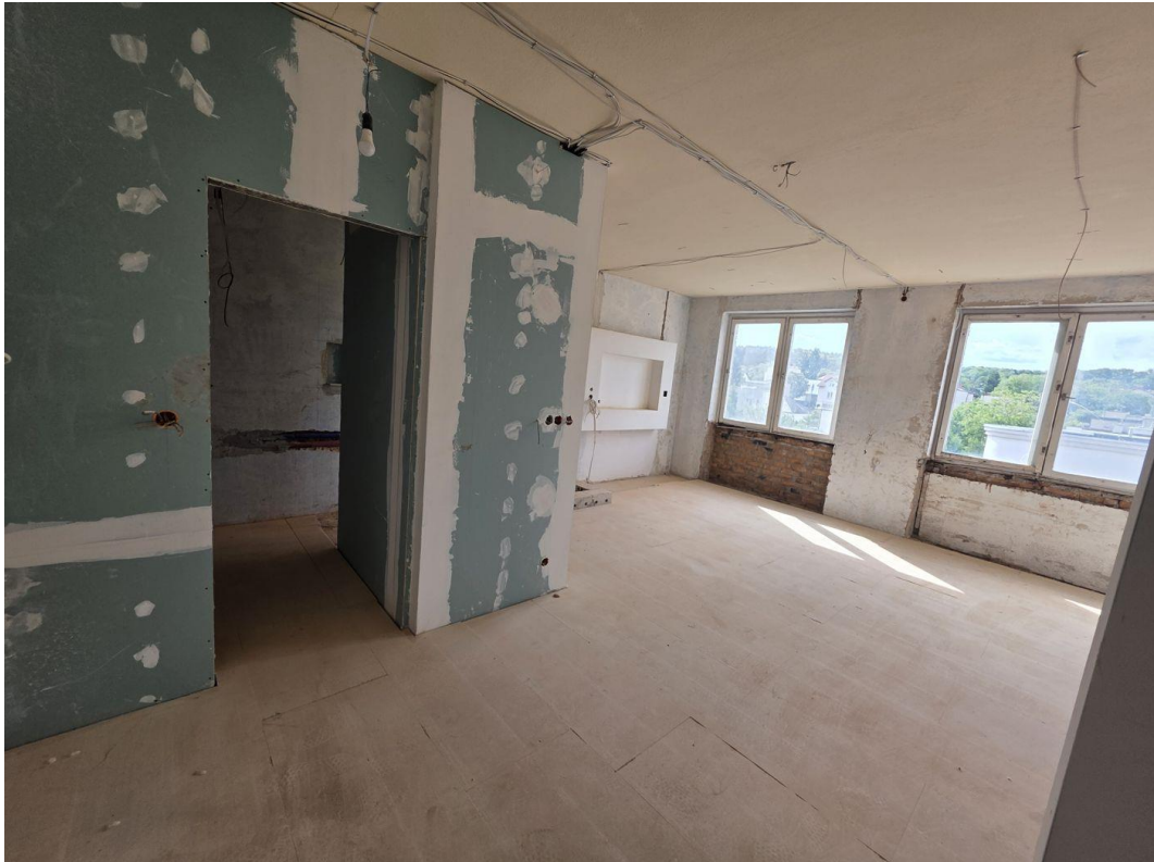
Fot. 9. Nowe ścianki działowe z płyt g-k (03.09.2026)
